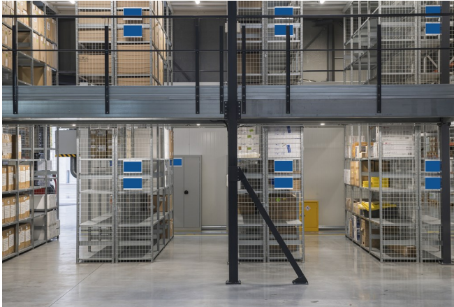
Freitragend auf eigenen Stützen – die Hallenstatik bleibt unbelastet.
