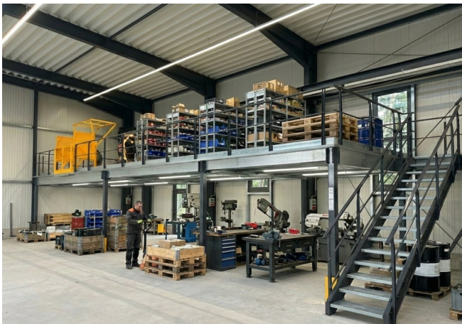
Kommissionierebene mit Fachbodenregalen bis an die Kante.
