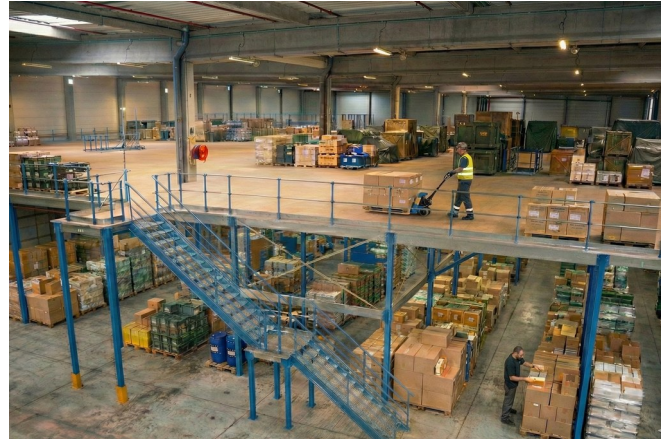
Große Stützenabstände halten die Fahrwege am Boden frei.
