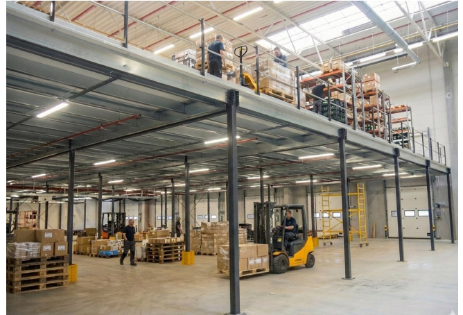
Montage ohne Schweißen – die Halle bleibt in Betrieb.
