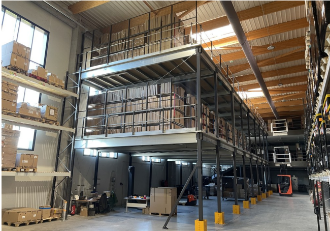
Zweigeschossige Anlage, im laufenden Betrieb montiert.
