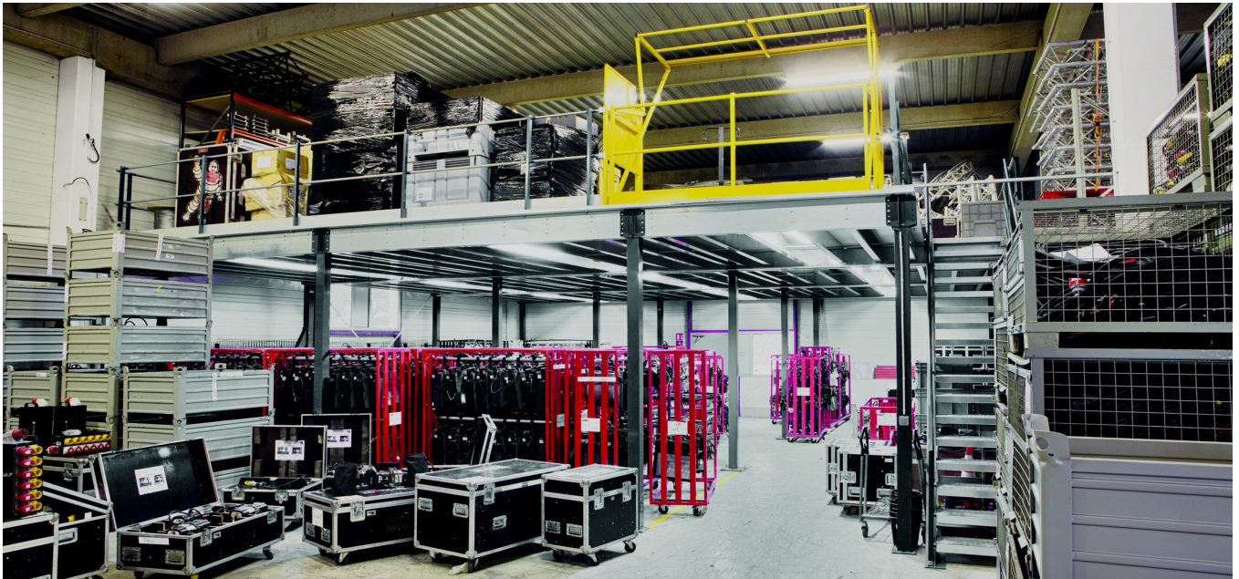
Zwischenebene in einem Pufferlager: Unten bleibt die Fläche voll nutzbar, oben entsteht eine komplette zweite Lagerebene.
