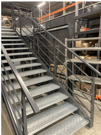
Industriertreppe mit Gitterroststufen, Steigung 35°, 38° oder 45°.
